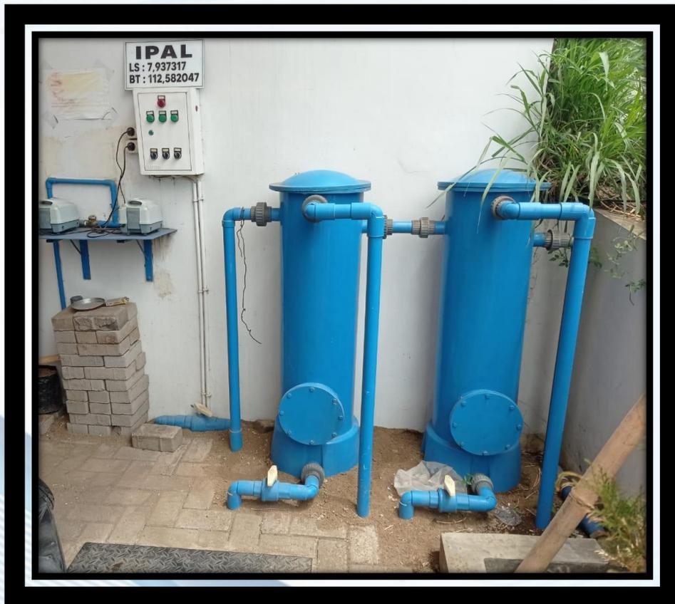
Limbah domestic diolah dengan menggunakan instalasi pengolah sederhana (septic tank), sedangkan limbah cair buangan dari dari kegiatan pelayanan kesehatan, diolah dengan IPAL biofilter (aerob-anaerob). Konstruksi IPAL dibuat dari beton bertulang dengan kapasitas 15 m<sup>3</sup> yang terdiri dari 4 kompartemen dengan Kapasitas 10.000 Liter
